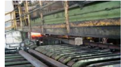
黑匣子安装在宝钢钢管管坯上
